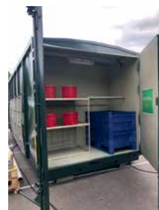
I enden av containeren er det eget rom for farlig avfall, gjenbruksprodukter eller lignende.
